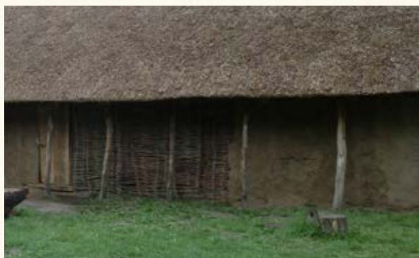
11: Muur die deels met leem is dichtgesmeerd
